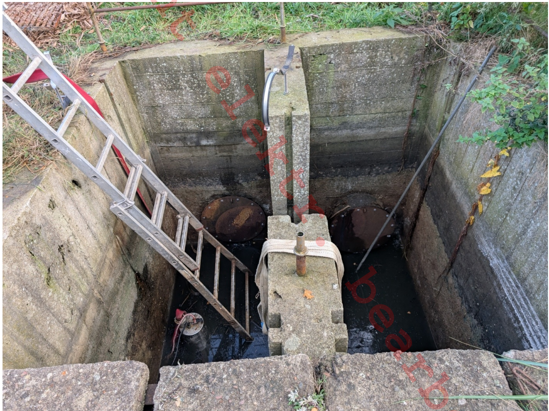
Schachtbauwerk teilentleert - Zulaufseite
